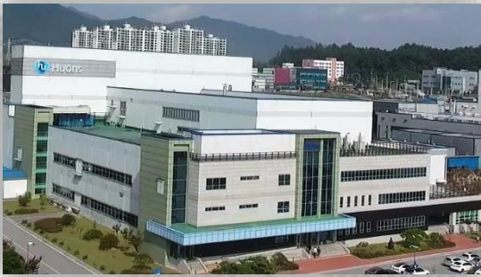
Huons Pharma Plant (Jecheon)
