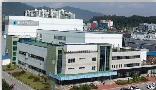
휴온스 의약품 공장(제천)
