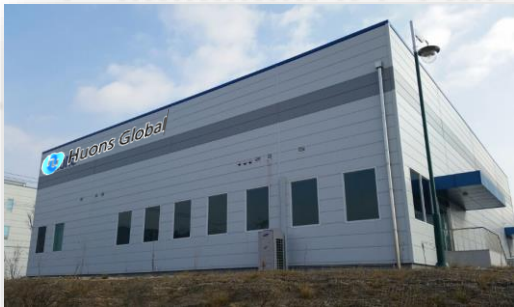
휴온스글로벌 보틀리눔 특신 공장(제천)
